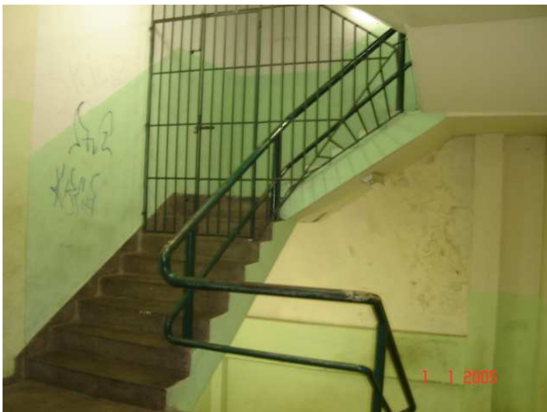
Foto 12: Escada que dá acesso ao auditório
